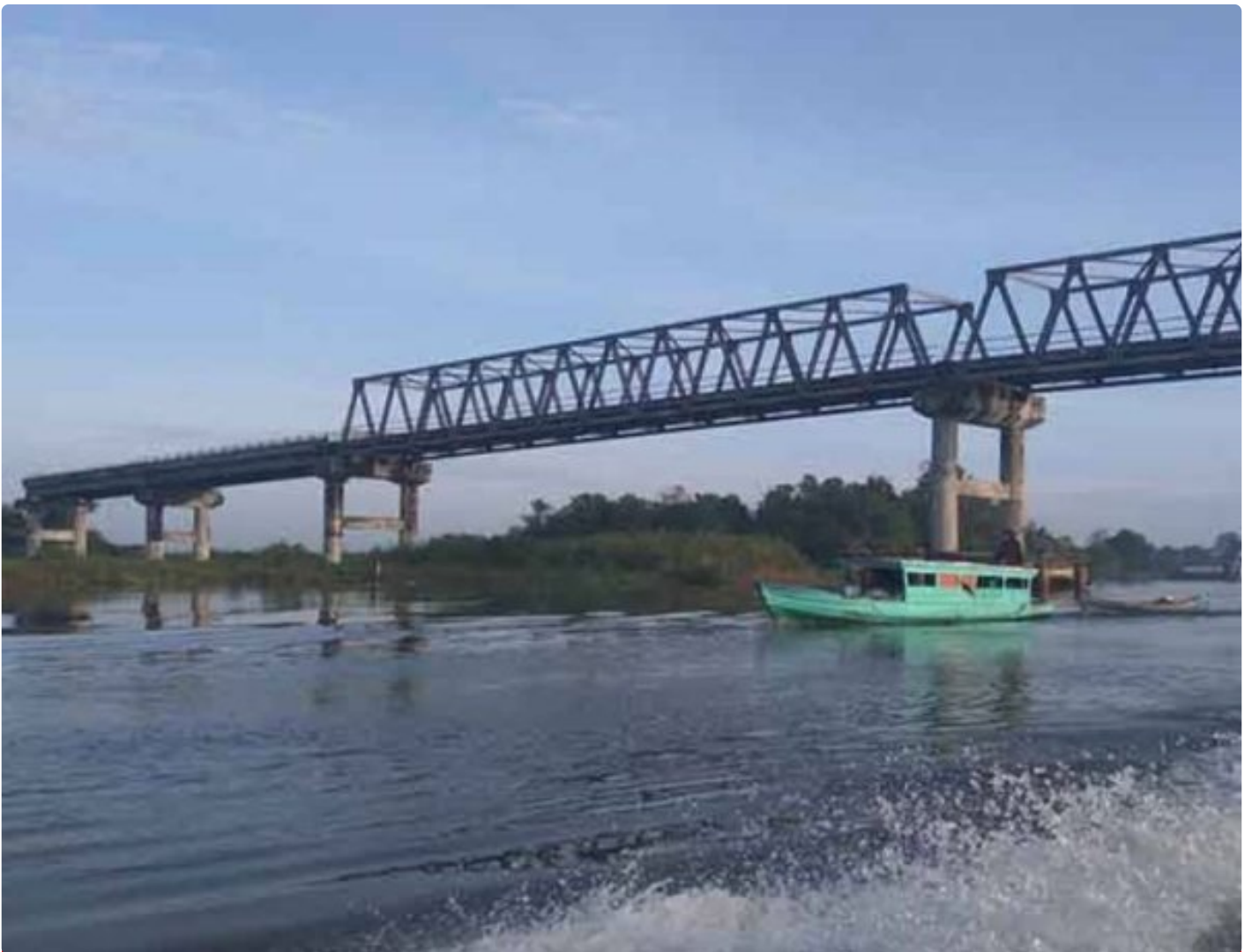
Jembatan Jelai di Kabupaten Sukamara
